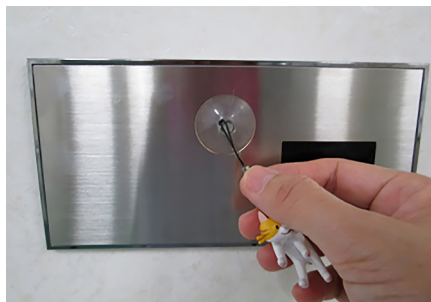
1. 吸盤でパネルを外します。
